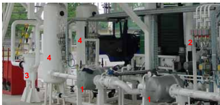
Contadores de carga Tipo OV 1000 (1) en una carga de camiones. cisternas con aditivos (2), Filtro (3) y separador centrífugo de gas (4)
