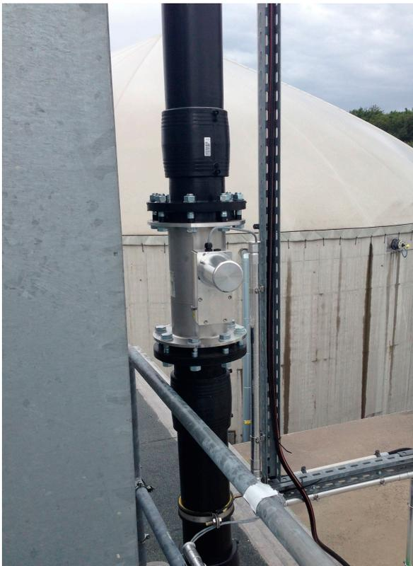
Instalación del medidor GD 300 en una tubería vertical descendente
